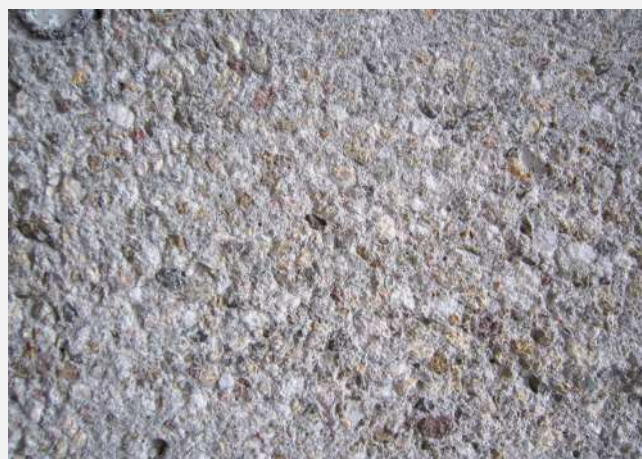
Результат подготовки основания методом бучардирования
