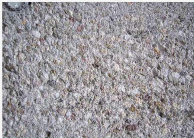
Результат подготовки основания методом бучардирования
