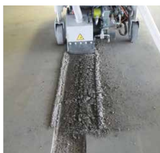
Осциллирующее фрезерование при небольшой рабочей массе
