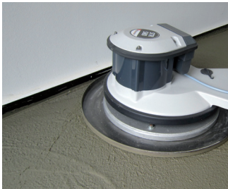
Заглаживание бесшовного пола
