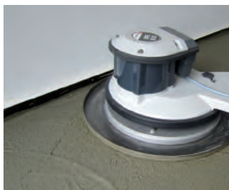
Заглаживание бесшовного пола
