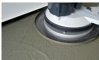
Затирка с помощью диска
