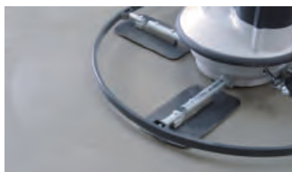
Заглаживание с помощью лопастей
