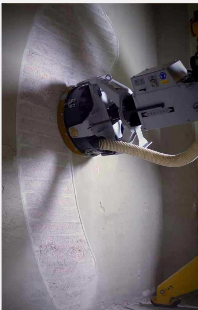
Демонтаж покрытия – сохраняет фасад и уменьшает затраты
